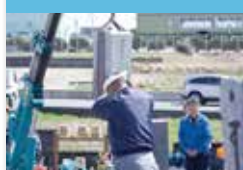
墓石の解体処分
