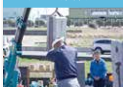
墓石の解体処分
